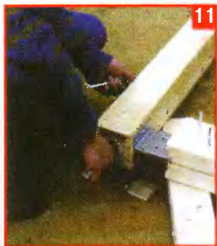
Стропила можно соединить с прогоном посредством металлических П-образных элементов, вставляемых в пазы.
