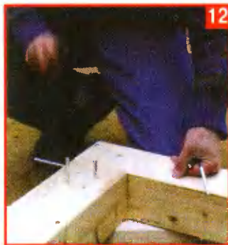
Чтобы усилить соединения, сквозь отверстия стоек и вставок в древесину забивают металлические стержни или заворачивают шурупы-«глухари».
